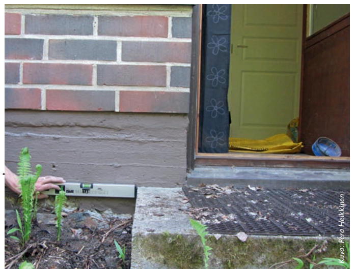
Kun ulko-oven alareuna on selvästi alempana kuin sokkelin yläreuna, on kyseessä valesokkeli.
