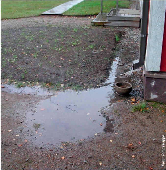
Vedenpoisto talon nurkalta ei toimi.
